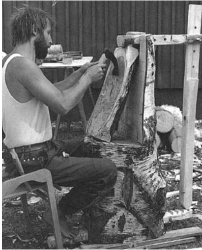
Trogklotz aus Avaträsk mit eingespanntem Werkstück. Bosse Persson arbeitet hier beim Kurs in Fågelsjö 1989 mit dem Dechsel.
