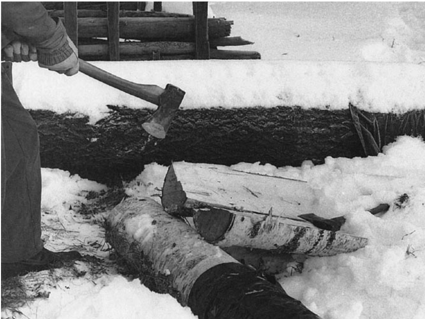
Längere Stücke sind leichter zu spalten, wenn man wechselweise mit zwei Äxten schlägt. Gerade gewachsenes Holz spaltet sich leicht.
