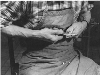
Ganzheitliches Bild des Hebelgriffs. Der Schnitt beginnt mit gerade nach außen gerichteten Ellbogen.
