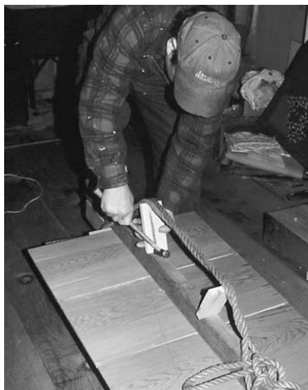
19 Mit Hilfe kleiner Holzstücke wird Druck auf die Bretter aufgebracht
